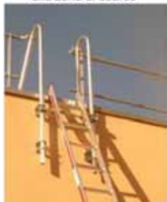
4. Scala portatile vincolata alla zona di sbarco
