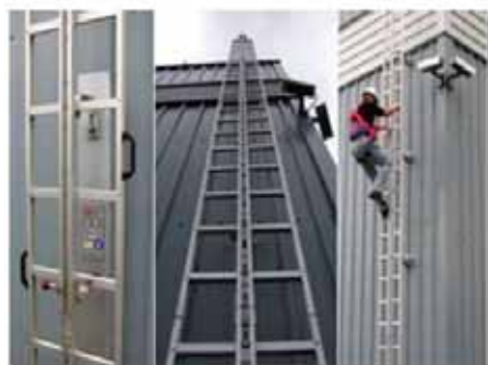
scala a due montanti dotata di dispositivo guidato guidato UNI 353.1
