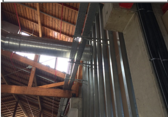
STAFFAGGIO A MENSOLA PER CANALINE ELETTRICHE TIPO 2
